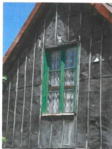
Bígr, 2014, novodobé izolace štítů
