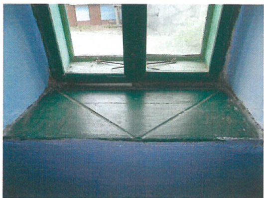
Bígr, 2014, objekt č. 42, dřevěný parapet S odvodňovacími žlábkami
