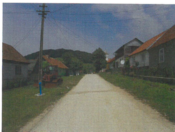
Bígr, 2014, pohled do ulice, kde došlo ke změně hmotových měřítek nástavbou domu
