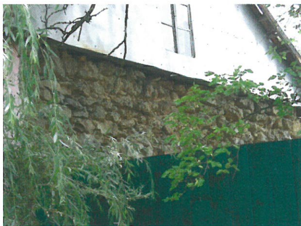
Bígr, 2014, zdivo obytného domu stavěného z lomového kamene
