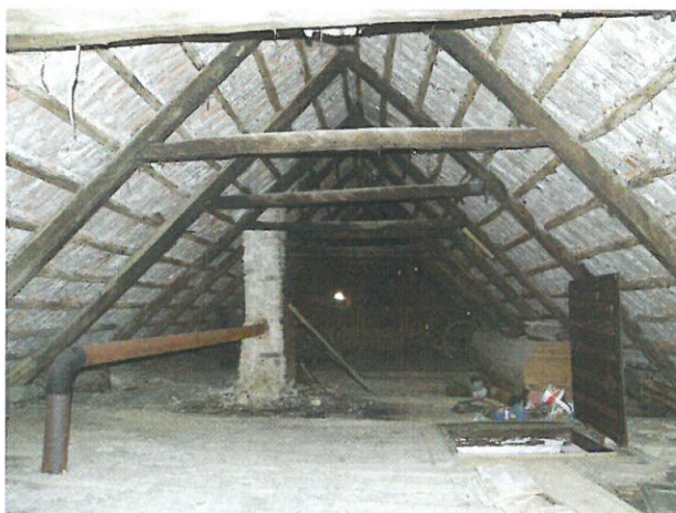
Bígr, 2014, objekt č. 42, krov hambalkového typu
