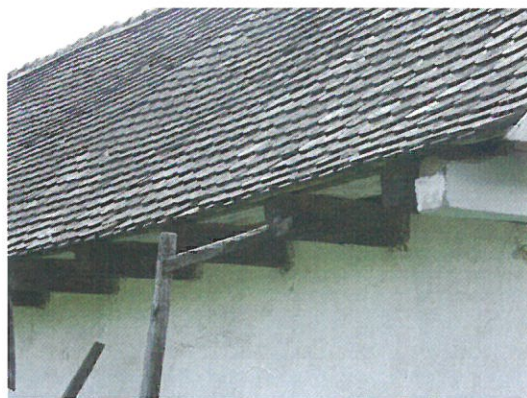
Bígr, 2014, objekt č. 31, zdivo přesahující stropní trámy
