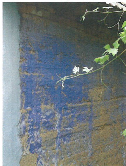
Bígr, 2014, objekt č. 26, truplované zdivo v hlíně jsou otisky dřevěného bednění
