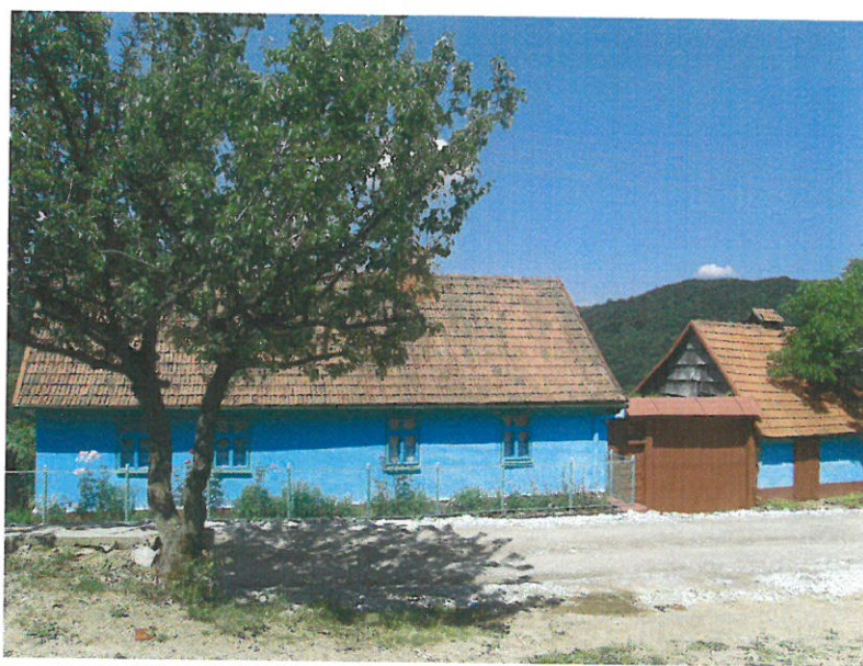
Bigr, 2014, nově opravená bývalá kovárna
