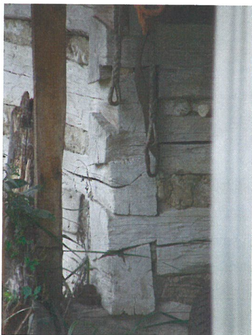
Bígr, 2014, detail roubení hosp.stavby
