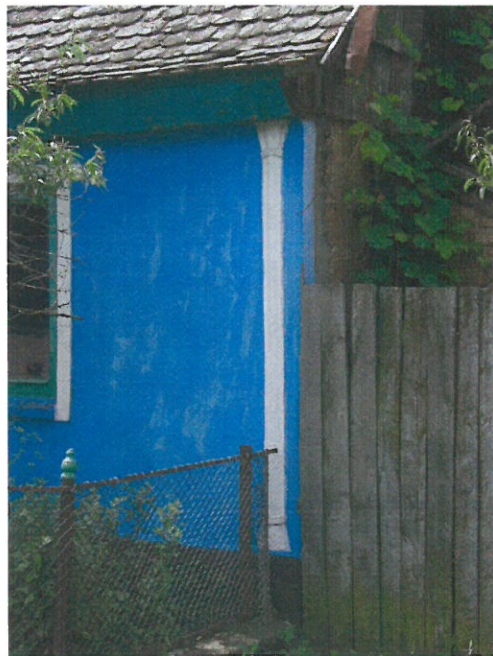
Bígr, 2014, objekt č. 22, štukový pilastr na průčelní fasádě
