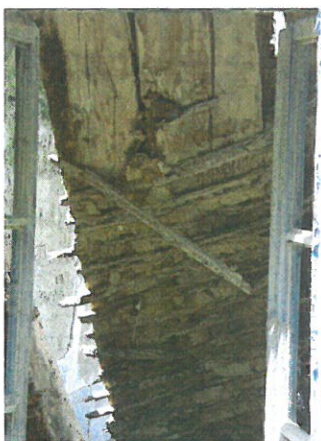
Bígr, 2014, objekt č. 17, detail stropního Záklopu s armaturami a hliněnou omítkou
