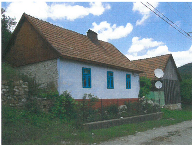
Bígr, jeden z pietně opravených objektů na konci obce při cestě na Hukvajdy
