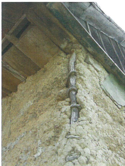
Bígr, 2014, objekt č. 32, nároží truplovaného zdiva provázané větví
