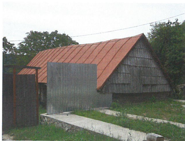
Bígr, 2014, roubená hosp. stavba s šindel.stítem
