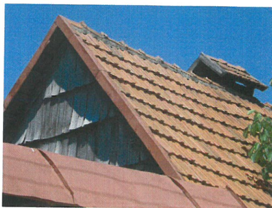
Bígr, 2014, objekt č. 7, bývalá kovárna, deštěný štít z desek a zavětrovacích lišt a nad hospodářskou budovou je dochován štít se šindelem
