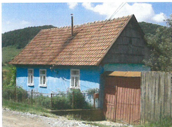
Bígr, 2014, objekt č. 2, okapová orientace
