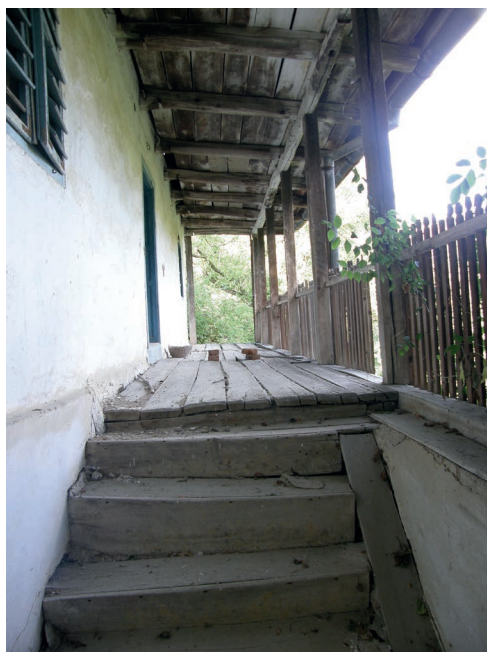
7.75 Dřevěné schody a dřevěná podlaha s lačkovým oplocením verandy.
