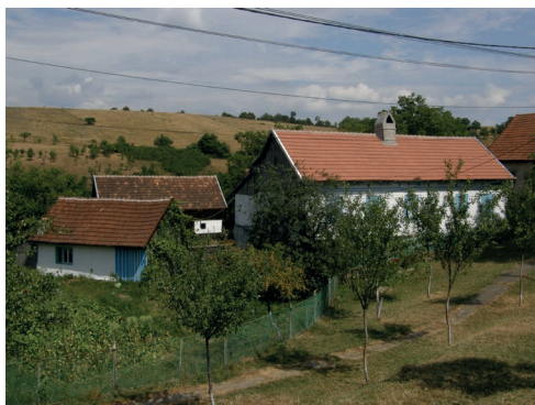
foto 4.33 Typickou krytinou banátských domů byla pálená taška.
