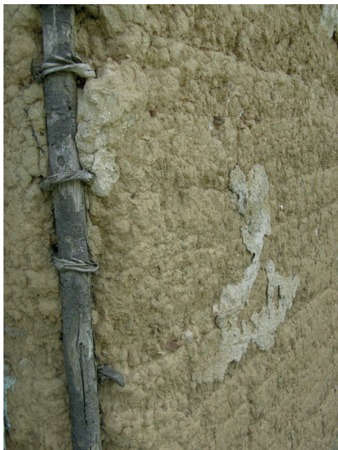
foto 2.11 Detail nároží armovaného větví a pruty zapuštěných truplovaných obvodových stěn domu.
