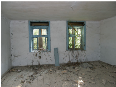
foto 6.60 Banátské domy v obytných místnostech měly dřevěné podlahy uložené na dřevěné hranoly – polštáře, polštáře byly uloženy do sypkého hlinitého a suchého náspu. Tento způsob podlah byl velmi prodyšný pro odvádění případné zvýšené vlhkosti v základech domu.
