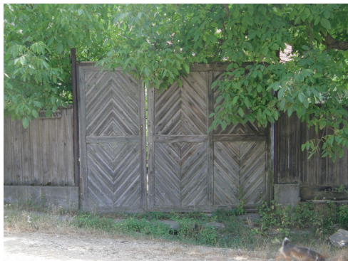
foto 7.70 Dřevěný vjezd do dvora z plných desek uložených na koso.
