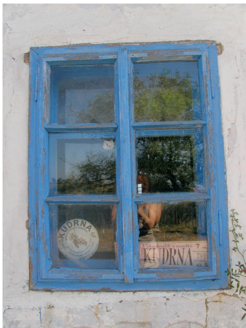
foto 5.43_c Příklad původního dvoukřídlového okna s příčlemi dělicími křídla na další tabulky. Tradiční modrý krycí nátěr. Výplň je usazena do líce fasády a venkovní výplně se otevírají ven.
