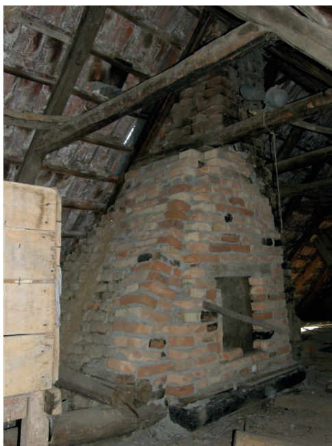
foto 4.42 Pohled z půdního prostoru na těleso komínového dymníku, které se kónicky zužovalo směrem nahoru.
