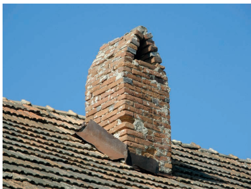
foto 4.39 Cihelný komín s typicky uzavřenou hlavou pomocí předsazených cihel.
