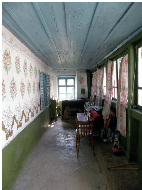
foto 6.63 Pohled do verandy domu. Původně otevřená veranda byla doplněna dřevěnými plnými výplněmi a okny. Podlaha byla vyлита betonem. Strop podbit deskami.
