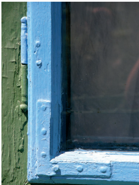
foto 5.49 Detail okenního závěsu. Jedná se o zadlabávaný závěs s kuličkou ve vrcholu. Rám okna zpevňuje kovový rohovník. Tento typ závěsů byl typický pro počátek 20.století.
