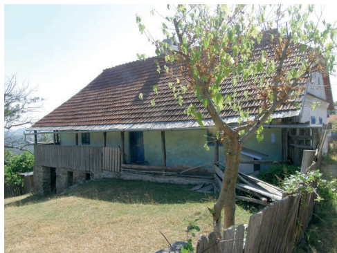
foto 7.74 Domy měly vždy na své delší okapové straně verandu. Jednalo se o prodlouženou střechou vynášenou na dřevěných sloupích doplněnou proti drůbeži jednoduchým lačkovým oplocením a dřevěnou deskovou podlahou.
