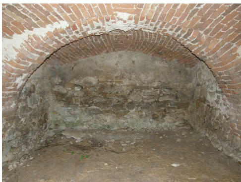
foto 6.64 Sklep s cihelnou klenbou pod domem. Podlaha je hliněná, stejné podlahy bývaly v kuchyních s otevřeným ohništěm a dymníkem.
