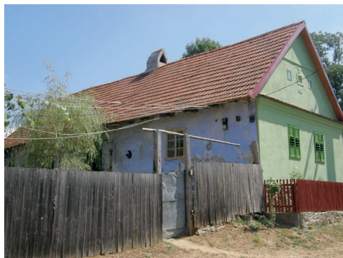
foto 3.28 Dům prošel v nedávné době rekonstrukcí. Omítka na průčelí vyhlíží jako dobře provedená, je jen škoda, že nebyly obnoveny štukové prvky v podobě rámců kolem oken a dekorů na nárožích. Fasáda vyhlíží prázdná a bez dekorů i jako plochá. Není zde kromě římsy žádný další prvek, který by pomohl docílit plastičnosti plochy.
