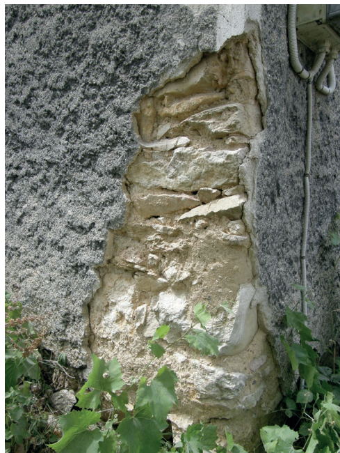
foto 2.16 Soklové omítky byly prováděny z hrubého materiálu s přísadou popela a uhlíků. To způsobovalo šedou až tmavě šedou barvu omítky. Důvodem přidávání popela bylo zlepšení vlastností omítek proti zvýšenému zavlhávání.
