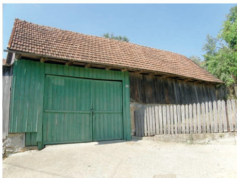
foto 7.67 Hospodářský objekt s branou a navazujícím deskovým oplocením s hrotitým zakončením. Brána je z desek doplněných tenkou zavětrovací zdobnou lištou.
