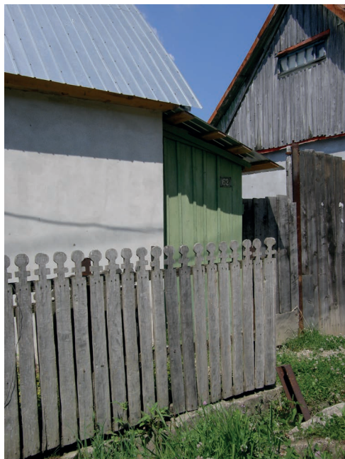
foto 7.68 Předzahrádky domů mohly být ohrazeny dřevěným nebo kovovým oplocením. Vždy bývalo více zdobné než oplocení v zadních částech pozemku. Toto dřevěné oplocení má dekorativně vyřezané horní části. Takováto zdobná úprava paradoxně uzavírala dřevo proti jeho další degradaci a rychlejšímu poškození.
