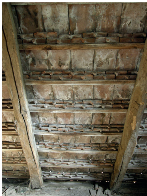
foto 4.36 Usazení pálené krytiny na latích, pohled z půdy
