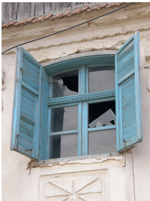
foto 5.46 Často se u banátských domů setkáváme se zvláštní kombinací vnitřní okenní výplně usazené do kastlíkového dřevěného rámu vetknutého do okenního otvoru a do něj zavěšené dvoukřídlové okenice usazené v líci fasády. Vnitřní výplň je převážně čtyř křídla, dvě spodní křídla a dvě malá horní otevíravá na provětrávání. Mezi křídly se nachází tzv. putec, většinou býval zdobný.
