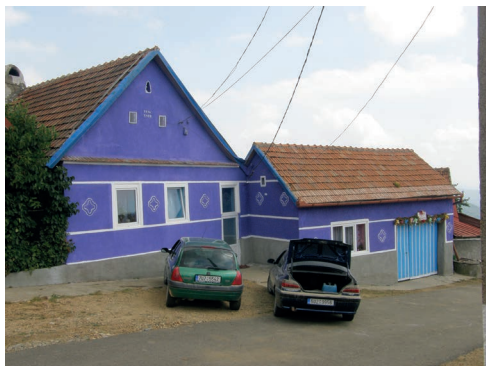
foto 3.26 Novodobá úprava fasády s tmavě fialovým fasádním nátěrem vyhlíží v banátských vesnicích rozpačitě a nepatřičně.
