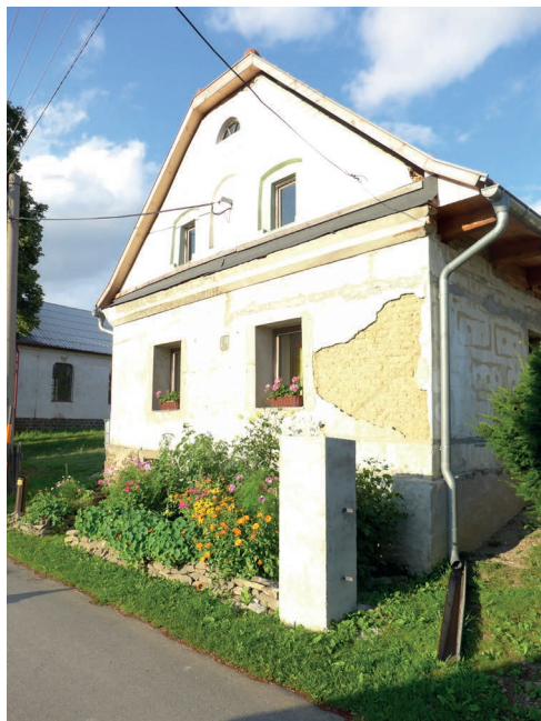
foto 5.43_b Průčelí domu s novými dřevěnými okny. Výplně jsou jednokřídlové, bez dalšího členění. Otevírají se dovnitř a jsou usazeny hlouběji do okenního otvoru. Dům vypadá, jako by ani žádná okna neměl.
