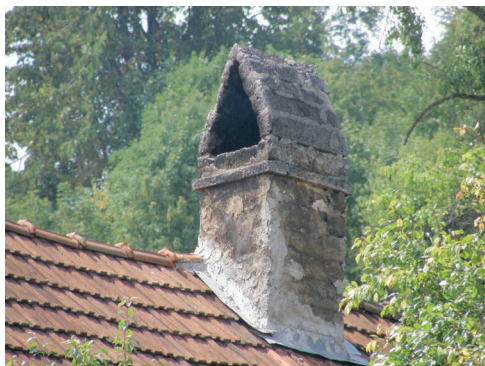
foto 4.40 Cihelný komín se zaklenutím doplněný omítkou s vytaženým límcem
