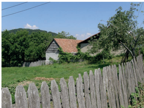
foto 7.66 Tradiční plot z desek s okosenými hranami. Poetika tohoto plotu spočívá právě v té nerovnosti a nepřesnosti. Do vesnického prostředí naprosto ideální oplocení.
