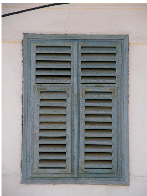
foto 5.51 Pohled na dvoukřídlovou lamelovou okenici kombinovanou s výklopnými křídly lamel.
