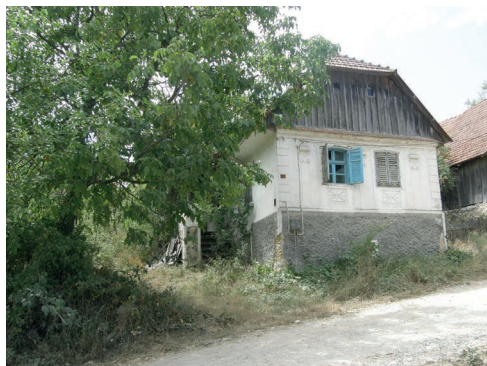
foto 1.2 Dům štítové orientace – jeho štítová kratší strana je souběžná se silnicí
