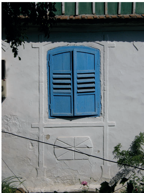
foto 3.22 Detail zdobení okna s plochou šambránou, pod oknem patrný vystupující obdélník s paprskovitou rozetou – typický prvek výzdoby banátských domů.
