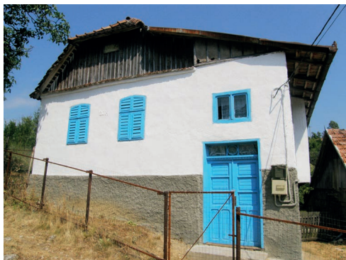
foto 1.7 Totéž viz. foto 1.6 při pohledu na průčelí
