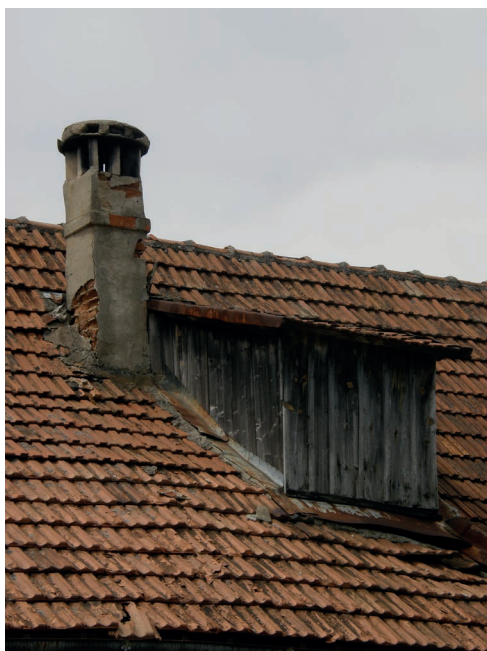
foto 4.41 Komínová hlavice je novým prefabrikovaným keramickým dílem. Střecha obytného domu je navíc netypicky doplněna pultovým vikýřem.
