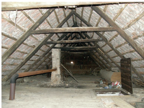
foto 4.30 Pohled na krov obytného domu. Jednoduchá konstrukce krokví rozepřená horizontálním hambálkem.
