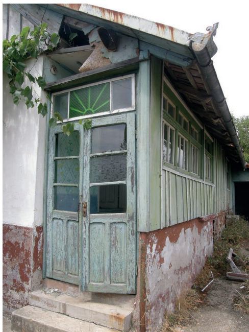
foto 7.76 Později se verandy uzavíraly, čímž docházelo k rozšíření obytných částí domu a jednak se tím více zateploval samotný dům, spodní části bývaly vyzdívány cihlou nebo plnými dřevěnými deskami, horní části doplňovány dřevěnými okenními výplněmi proti dešti.
