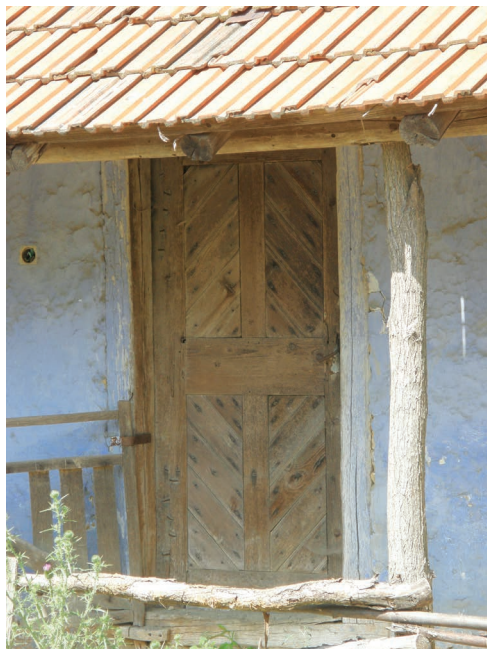
foto 5.58 Venkovní vstupní dveře do domu – rámová výplň se svlažky uloženým na rybinu.
