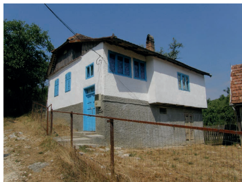
foto 1.6 Dům štítové orientace. Původní veranda usazená podél domu byla rozšířena, zvýšena a téměř celá obezděna. To způsobilo výraznou změnu sklonu střechy. Protože se objekt nachází ve svahu a v rozvolněné zástavbě, tak se jeho přístavěná veranda v nadměrné hmotě výrazně uplatňuje do okolí. Nadimenzovaná hmota není k hmotě domu proporční a v rámci celku působí rušivě.
