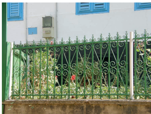
foto 7.69 Kovové novější oplocení předzahrádek asi ze 70. – 80.let 20.století. . Do betonové podezdívky byly usazeny napevno kovové sloupky a mezi nimi vloženo kovové dekorativní pole. Pole většinou bývala opatřena krycí barvou.
