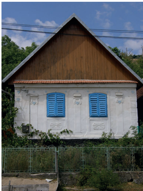
foto 3.21 Štít domu s úpravou fasády ze 30. let 20. století. Detaily výzdoby jsou zvýrazněny šmolgově modrým fasádním nátěrem.
