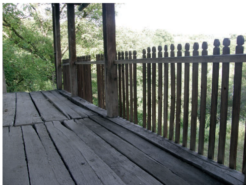
foto 6.62 Detail dřevěné venkovní podlahy verandy. Veranda tohoto domu byla umístěna vysoké zděné podezdívce. Konstrukce nebyla ve styku se zemní vlhkostí.
