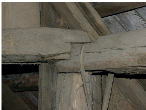
foto 4.32 Detail jednoduchého spoje poukazující na to, že propracovanost tesařských spojů nebyla v tomto případě příliš precizní.
