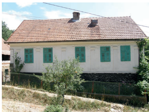
foto 3.19 Dům okapové orientace se starší výzdobou fasády, která prochází průběžnou rekonstrukcí při zachování původních štukových prvků i jejich rozvrhu. Způsob výzdoby odpovídá období 20. – 40. let 20. století.
