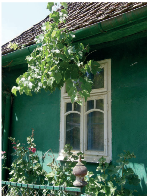
foto 5.45 Další příklad historického dřevěného okna s horním vyklápěcím křídlem a spodními otevíravými křídly směrem ven. Rozmanitost členění dodávají oknu výjimečně tenké mírně ohýbané okenní příčle.
