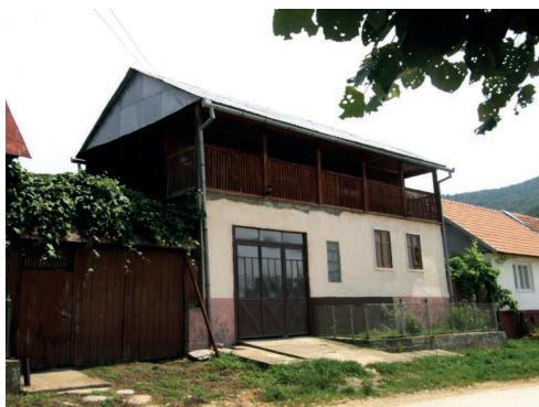
foto 1.8 Dům okapové orientace navýšený o celé jedno podlaží, do ulice po celé délce je situována lodžie.
