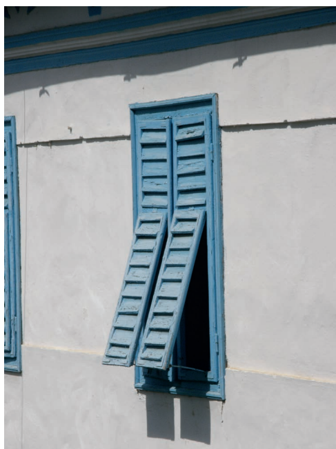
foto 5.52 Pohled na dvoukřídlovou lamelovou okenici s vyklapnými křídly.
