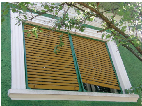
foto 5.53 Novodobé okno i s dřevěnou shrnovací žaluzií. Jedná se o výplň ze 70. nebo 80. let 20. století.
