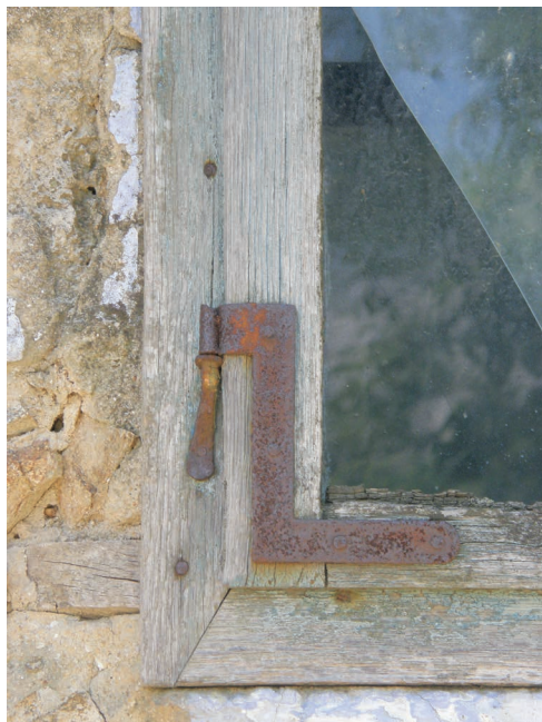
foto 5.50 Další detail okenního závěsu. Jedná se o starší typ ze druhé poloviny 19. století. Rohovník zpevňující dřevěný rám v rohové partii je propojen s okem do nějž se vsazoval hák.
