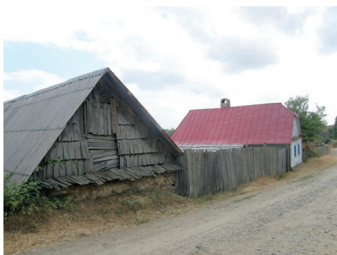
foto 4.35 Novější krytinu na banátských domech tvoří převážně plech – v plátech na obytném domě, někdy i vlnitý plech převážně na hospodářských objektech.
