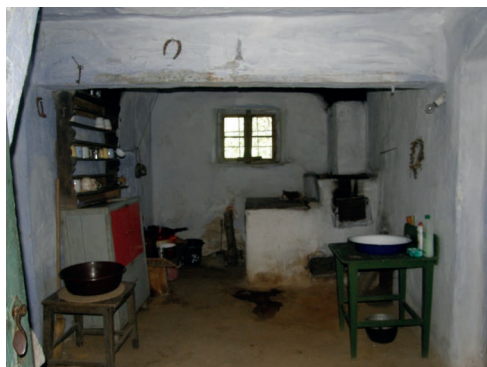
foto 6.65 Stará kuchyň banátských domů. Hliněná podlaha, dymník – velký komínový sopouch, který odváděl dým z místnosti, kde se vařilo na otevřeném ohni. Později bylo ohniště nahrazeno kamny s litinovými pláty na vaření.
