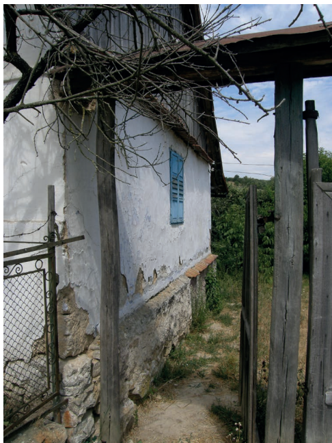
foto 2.12 Dům navýšený o celé jedno podlaží. Nástavba proběhla asi v 70.-80. letech 20. století. Protože se dům nachází spíše v rozvolněné zástavbě a v meandrech potoka, jeho navýšení není v rámci celku až tak patrné. Situace by byla horší při hlavních cestách s pravidelně usazenými domy.
