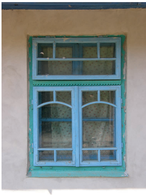
foto 5.44 Příklad mladší okenní výplně asi ze 30. let 20.století? Výplň je trojkřídlová, dvě obdélná spodní křídla se otevírají ven. Horní obdélná výplň je výklopná. Křídla jsou krásně doplněna drobnějšími příčlemi a opatřena tradičními krycími nátěry v modrých a zelenavých barvách.
