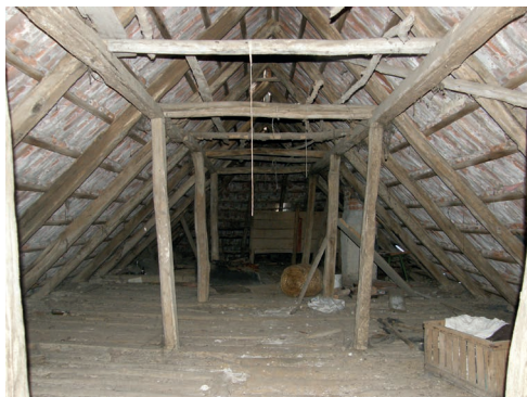
foto 4.31 Pohled na krov obytného domu. Jednoduchá konstrukce krokví rozepřená hambálky je navíc doplněná středovou průběžnou vaznicí, kterou podpírá soustava stojatých sloupků.
