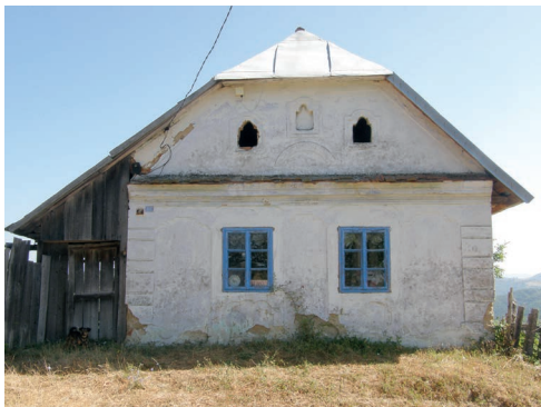
foto 5.43_a Průčelí domu s původními dřevěnými dvoukřídlovými okny dělenými příčlemi na menší tabulky, výplně jsou usazeny do líce fasády a venkovní křídla se otevírají ven.
