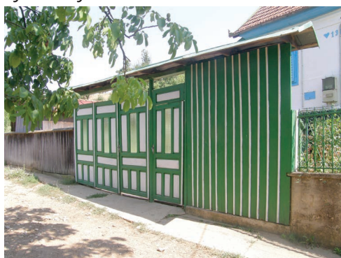
foto 5.59 Vstupní trojkřídla vrata do dvora a dveře. Brána je doplněna stříškou proti zatékání dešťové vody. Jedná se o novější truhlářský výrobek asi ze 70. nebo 80. let 20. století. Téměř u všech banátských domů se nachází již tento novější typ brány. Důvodem je rychlá degradace a časté používání, které zřejmě původní výplně rovněž poškodilo.
