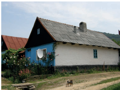
foto 3.27 Fasády banátských domů byly zvýrazňovány a dekorovány štukovou výzdobou výhradně na straně směrem do ulice. Zbývající fasády byly opatřovány pouze hrubou utahovanou omítkou s finálním vápenným nátěrem.
