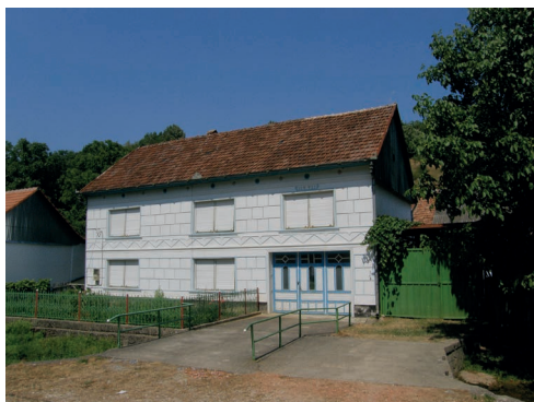
foto 1.3 Dům navýšený o celé jedno podlaží. Nástavba proběhal asi v 70. -80. letech 20. století. Protože se dům nachází spíše v rozvolněné zástavbě a v meandrech potoka, jeho navýšení není v rámci celku až tak patrné. Situace by byla horší při hlavních cestách s pravidelně usazenými domy.
