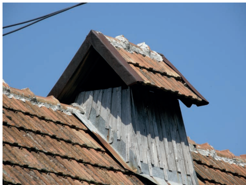
foto 4.37 Opláštění komína dřevěným dešťením. Otázkou je, zda pod opláštěním je komín vyzděný z cihel, či jílová omazávka na proutěnou armaturu.
