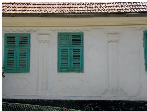
foto 3.20 Detail štukové výzdoby fasád ze 30. let 20. století. Mezi okny jsou patrné pilastry s dekorovanou hlavicí a s odstupňovanou patkou. Plochá šambrána kolem okna je výrazně zdobena v horní i spodní části okna.
