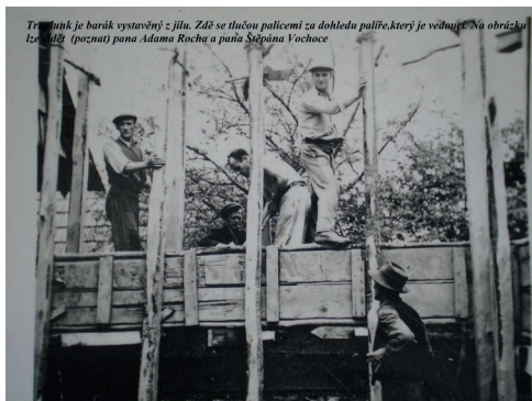
foto 2.0 Stavba truplovaného zdiva (fotografie pana Mleziy z Bigrú)
